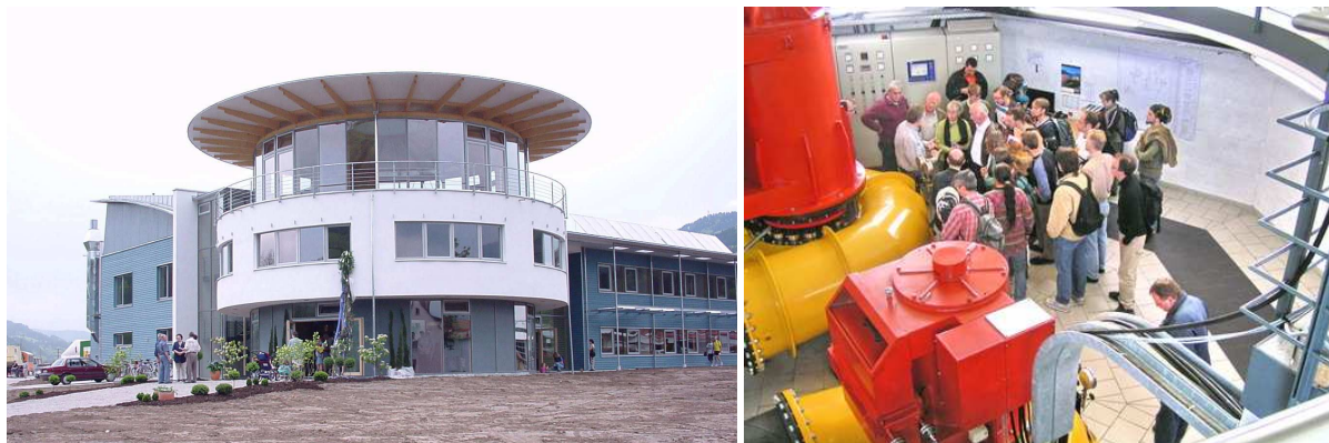
Wasserkraft Volk AG: li.: rundes Kraftwerks- und Verwaltungsgebäude, re.: 2 Turbinen (gelb) mit Generatoren (rot) Fotos: © Georg Löser, 26.4.2008
